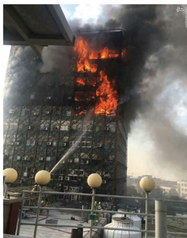
شکل ۲-۱۷. توسعه عمودی حریق در ضلع شمال غربی
