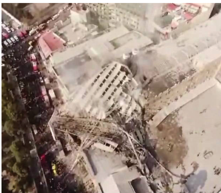
شکل ۱-۵. ساختمان پلاسکو پس از فرو ریزش
