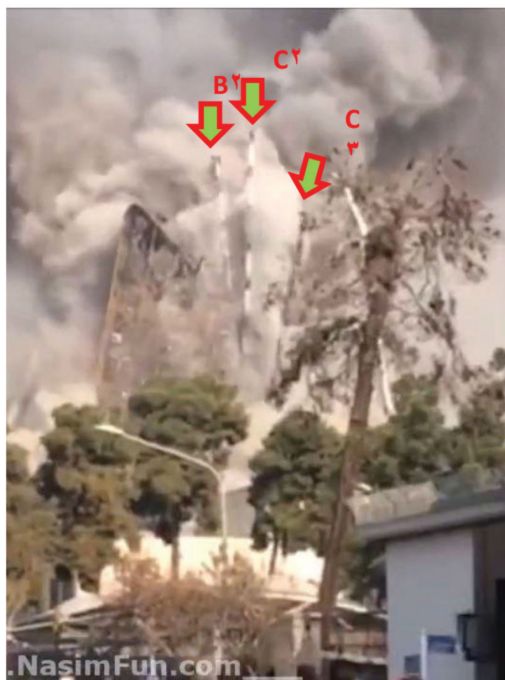
شکل ۲-۱۵. ستون‌های میانی سازه در حال سقوط در محل خود
