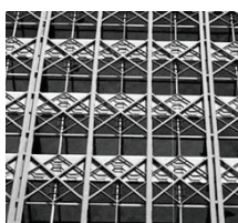
شکل ۷-۲. خرابای پیرامونی ساختمان
