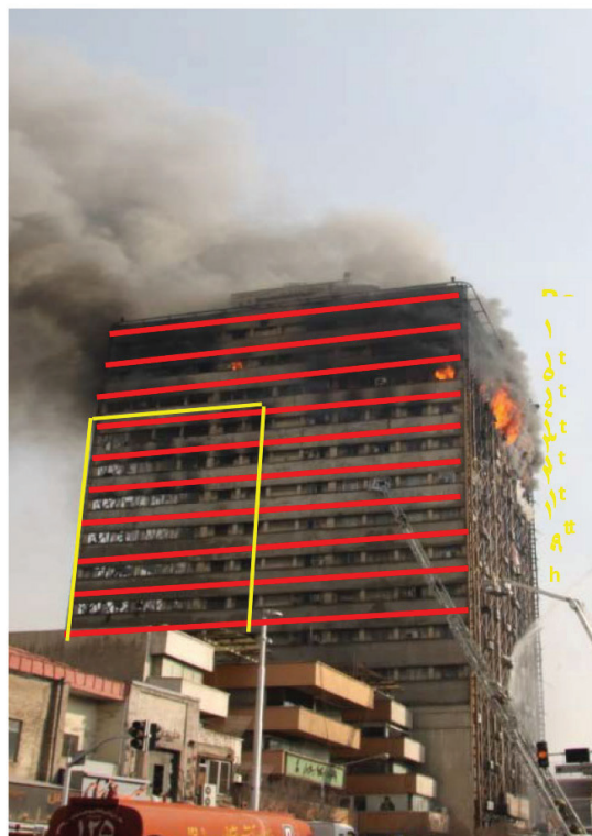
شکل ۲-۱۱. خرابی مرحله دوم، فرو ریزش سقف قسمت‌های مشخص شده (رنگ زرد)
